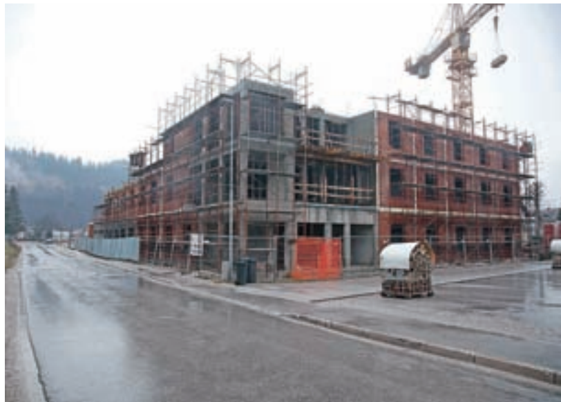
V Žireh hitro napreduje gradnja doma za starejše.
